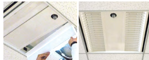
③ LEDユニットの取付
