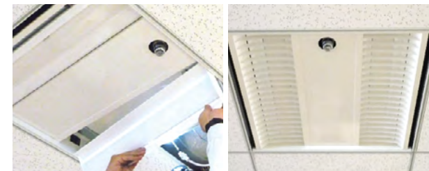
③ LEDユニットの取付
