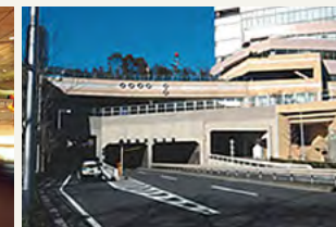
環状3号線・毛利庭園側
