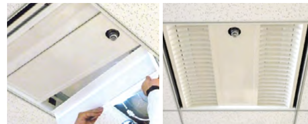
③ LEDユニットの取付
