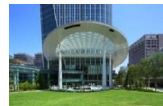
屋上庭園「オーバル広場」
