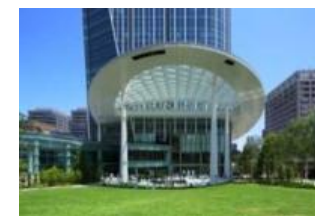
屋上庭園「オーバル広場」
