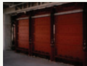
粘性体制振壁
