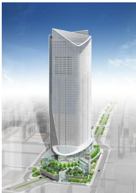
超高層棟全景 (注2)
